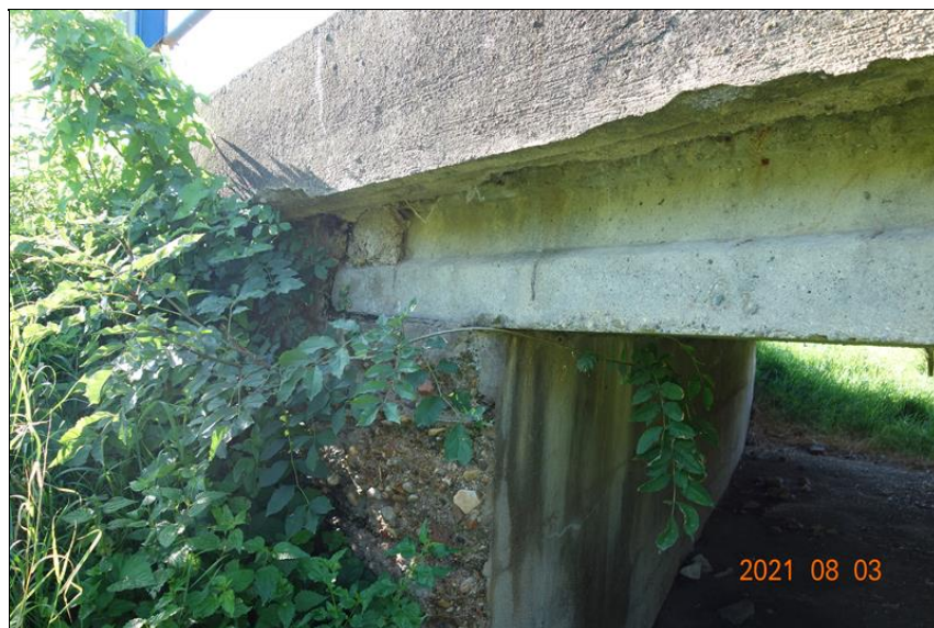
Detail uložení krajního nosníku na levé straně OP2.
