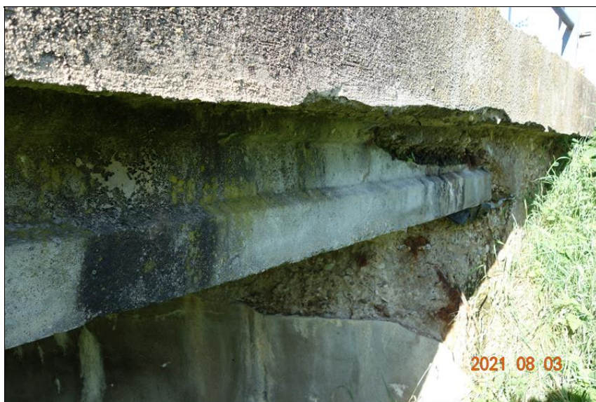
Detail uložení krajního nosníku na levé straně OP1.
